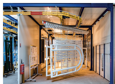
Etape 6 : Les menuiseries se dirigent vers un tunnel de séchage, où elles vont rester quelques heures avant d'être décrochées pour être amenées à l'atelier suivant. © Mario Tarantini.
